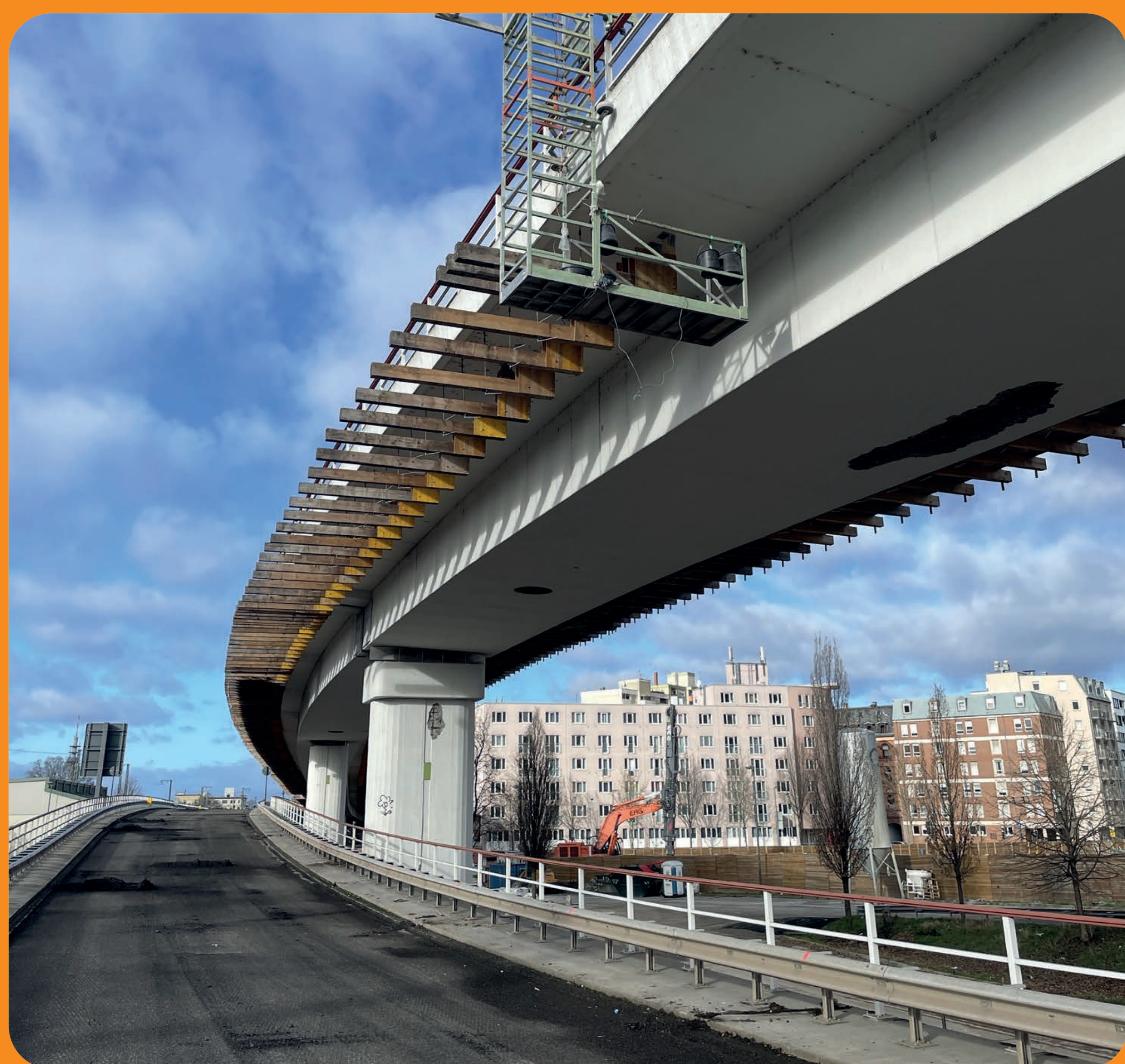
Die Modernisierung der Weißen Hochstraße, Stand März 2024
