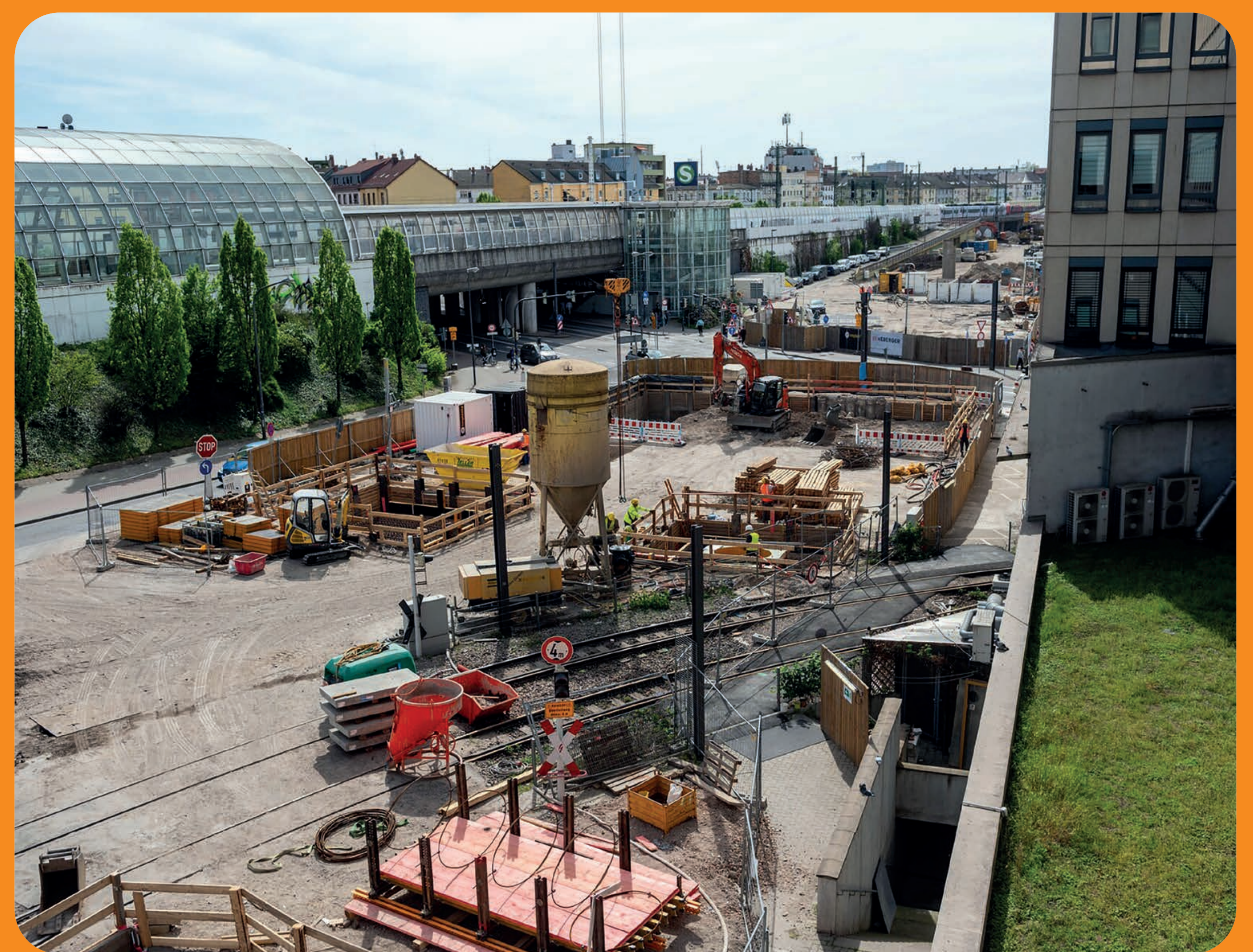
Die Bauarbeiten für den Ersatzbau zwischen Faktorhaus und S-Bahnhof, Stand April 2024
