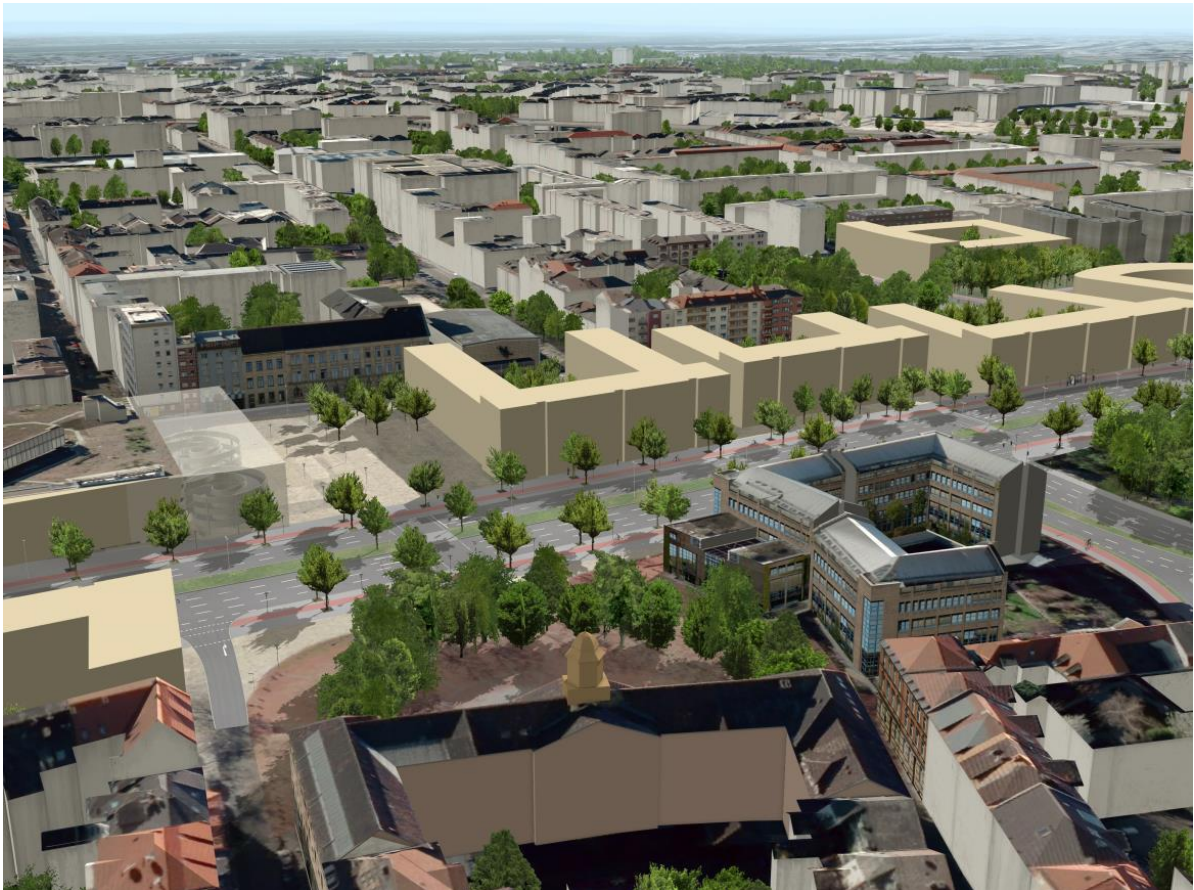
Ludwigsplatz Blickrichtung Straßenbahnhaltestelle
